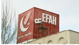
Kapatma kararının ardından Refah Partisi genel merkezinin çatı tabelası sökülürken
